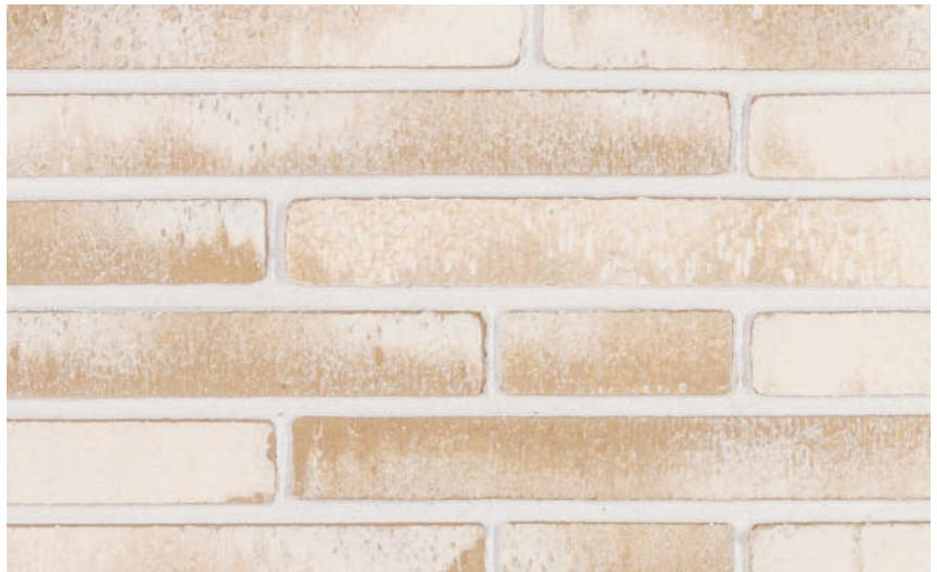
Pour l'aménagement des façades de l'ensemble Marcuskaje, les briques ont été spécialement fabriquées en accord avec les plans des concepteurs, d'aspects et de formats divers. Le revêtement d'une épaisseur d'à peine 4 à 6 millimètres est extrêmement plat et, malgré cela, robuste. Particulièrement légères, elles furent simplement collées au support.
